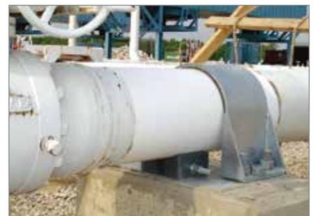
石油&天然气：减少来自旋转设备的振动，以及管道上的热膨胀
