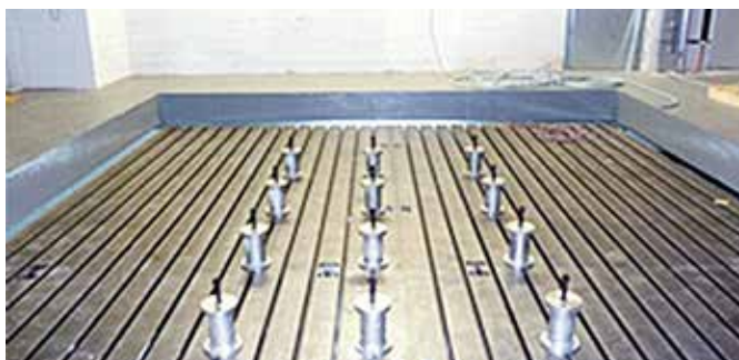
铁地板安装固定
