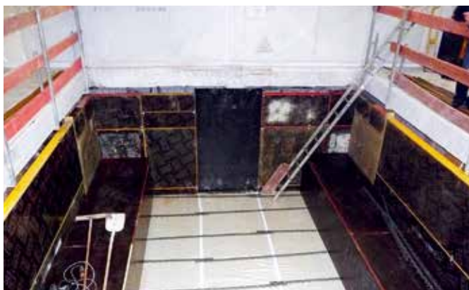
基础隔振模板工程
