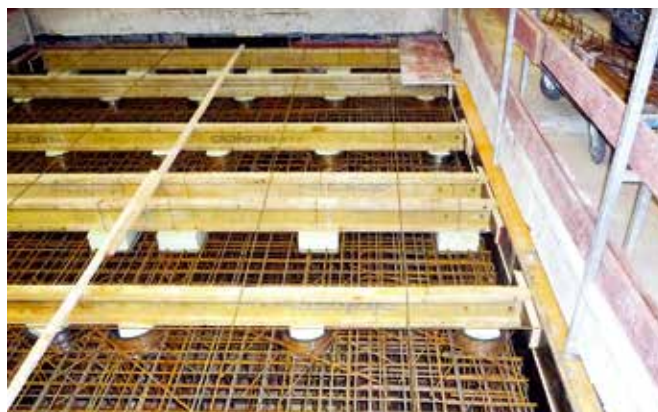
基础隔振钢筋锚杆系统
