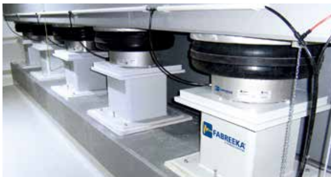
RLA 空气弹簧安装调试 (带精密水平阀)
