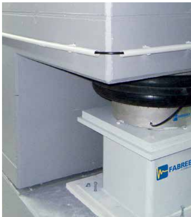
完工后的隔振基础
