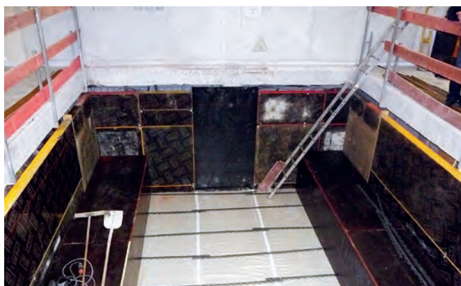
基础隔振模板工程
