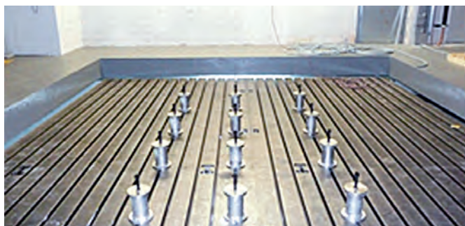
铁地板安装固定
