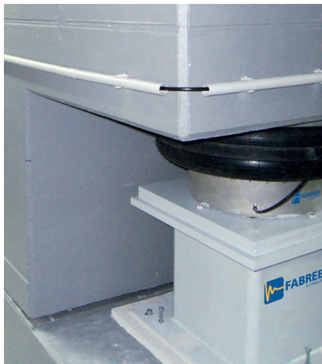
完工后的隔振基础
