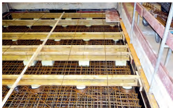
基础隔振钢筋锚杆系统
