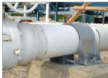
石油&天然气：减少来自旋转设备的振动，以及管道上的热膨胀
