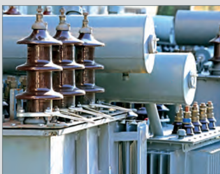
发电设备：减少变压器和变电站设备产生的噪音和振动
